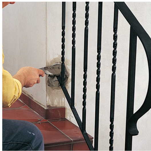
Typische Anwendung: Montage eines Treppengeländers.
