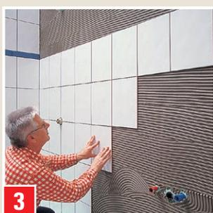
Insérer et aligner les carreaux dans les 30 minutes.
