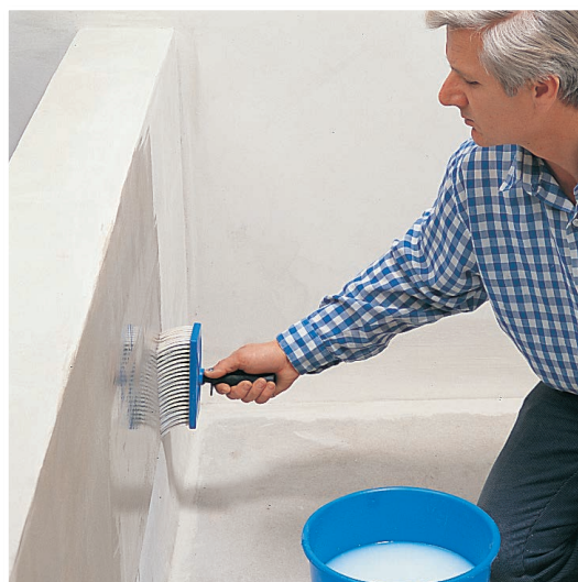
Apprêter un crépi absorbant avant les travaux suivants, p. ex. application de peinture.
